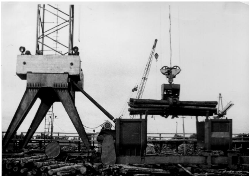
Рис. 1. Система башенный кран (1) и передвижной торцевыравниватель (2) на Кировской ЛПБ
