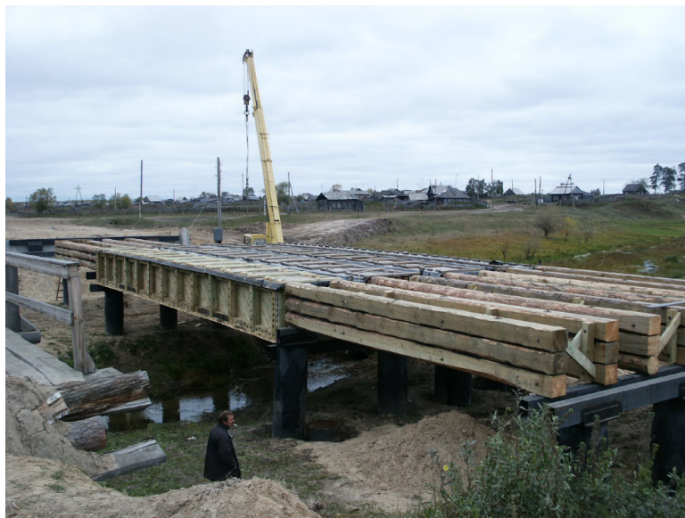
Рис. 4. Пролетное строение моста через р. Ушайра с составными прогонами из бревен
