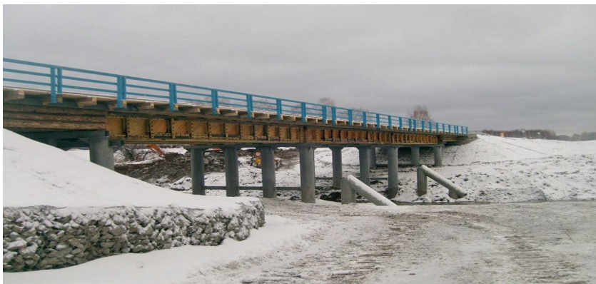
Рис. 11. Мост через р. Оша с 3 дощато-гвоздевными блоками в сечении 15-метровых пролетных строений
