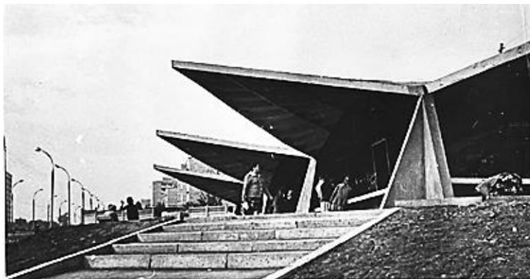
Рис. 3. Сборное составное гиперболическое покрытие рынка (размер 36×24 м)
