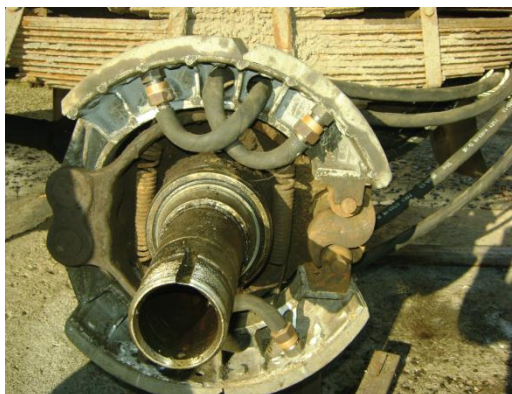
Рис. 3. Установка штуцеров в тормозных колодках
