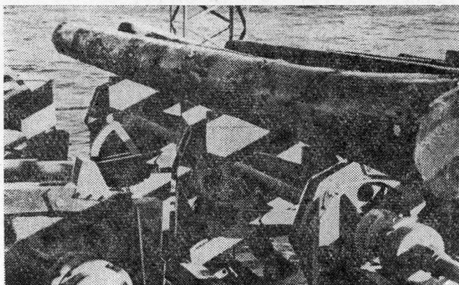
Рис. 1. Подача бревен в люльку поперечным транспортером.
