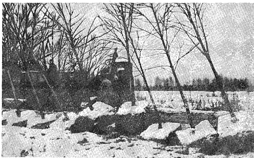
Рис. 3. Погрузочная площадка, размещенная вблизи дороги.
