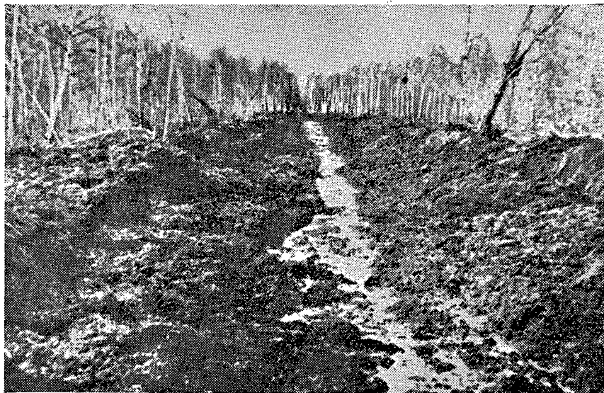
Рис. 1. Магистральная траншея на лесном болоте Барлакского совхоза Новосибирской области, образованная взрывом шнурового заряда.
