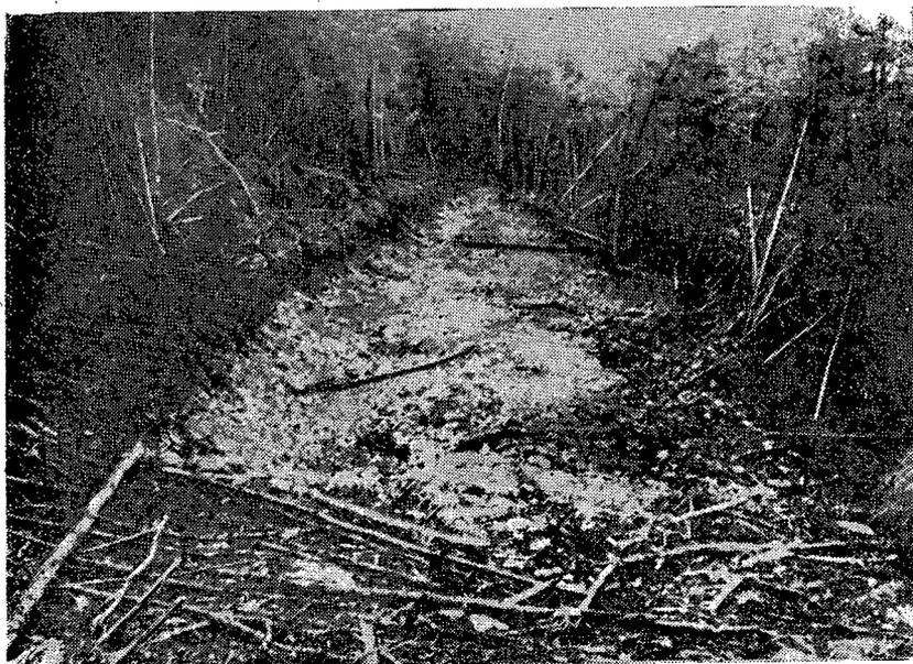
Рис. 4. Пасечный трелевочный волок, приготовленный бульдозером (Тетюхинский леспромхоз).
