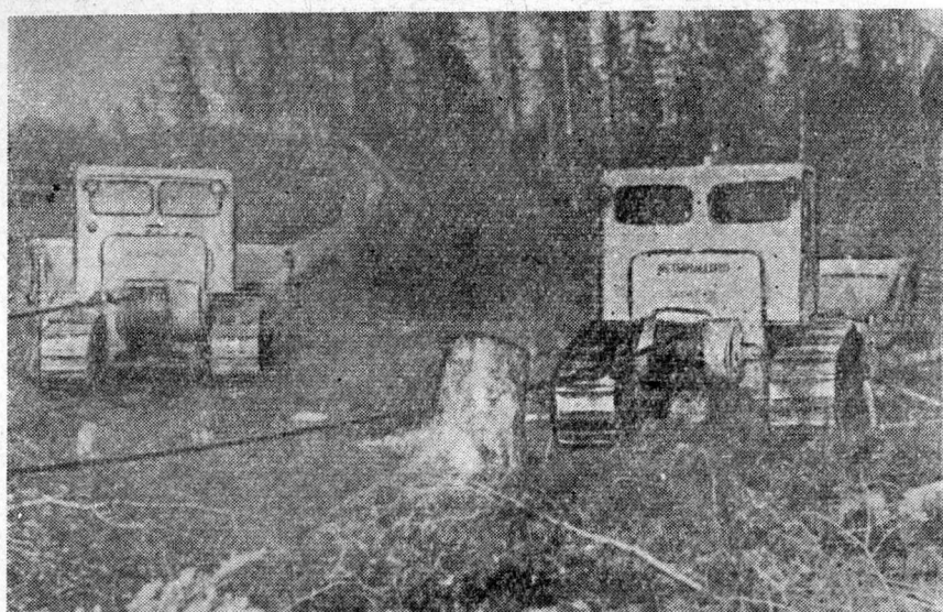
Рис. 5. Выкорчевывание остатков древостоя на лесосеке условно-сплошной рубки с помощью двух 120-сильных тракторов.
