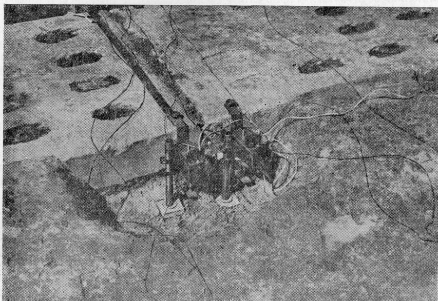
Рис. 3. Установка вибрографов для записи просадок и взаимного смещения плит.
